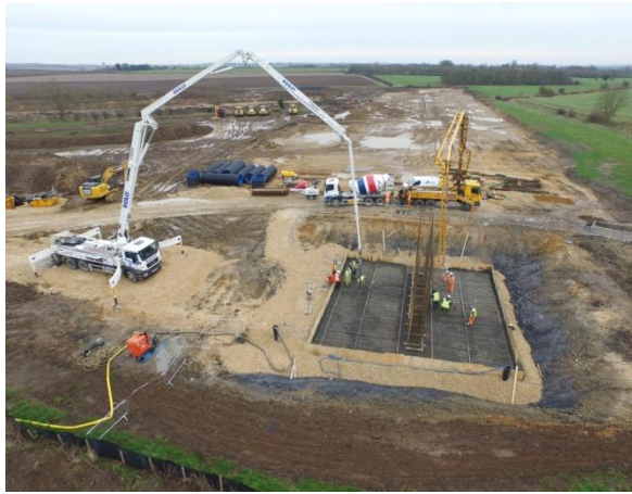
Concrete pour to base of control structure
